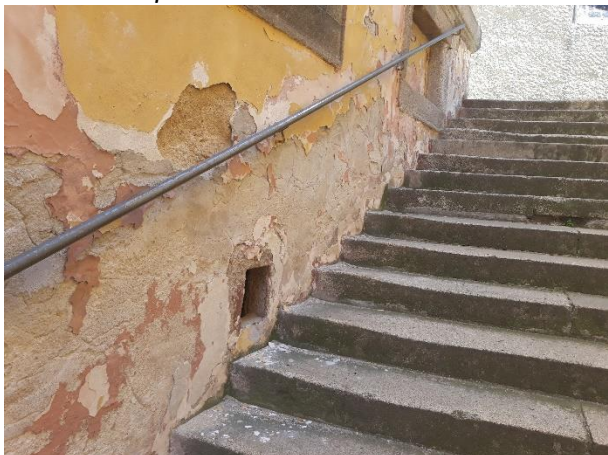
Eroze zdiva přilehlého ke schodišti
